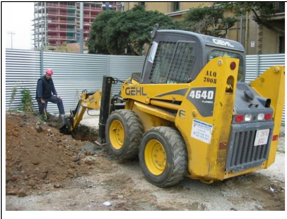
Fotografia 2. Inici dels treballs mecànics.
