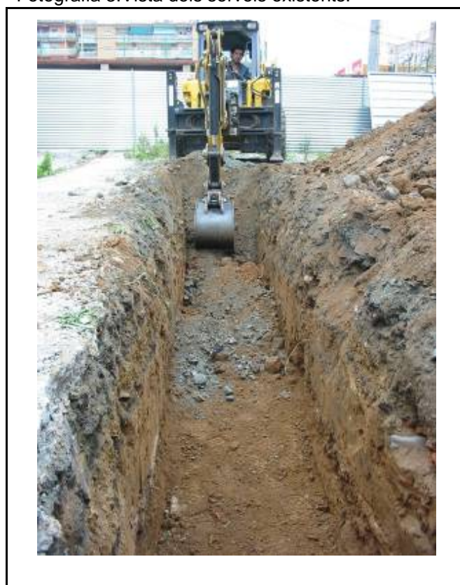
Fotografia 4. Rebaix mecànic de la rasa.
