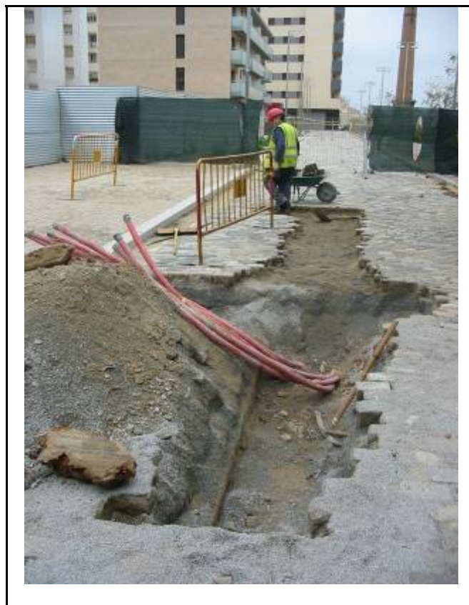
Fotografia 3. Vista dels serveis existents.
