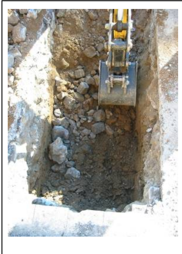
Fotografia 5. Vista del nivell excavat.
